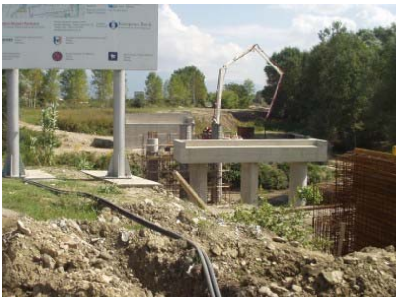
Bro under anlæg nær Moder Teresa-lufthavnen i Rinas, Nordvest for Tirana. Foto: Bjørn Andersen, 2005.
