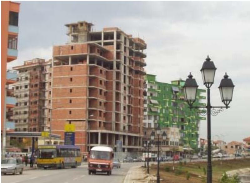
Nye huse ved Lana-floden tæt 1 km fra Tirana's centrum. Foto: Bjørn Andersen, 2005.
