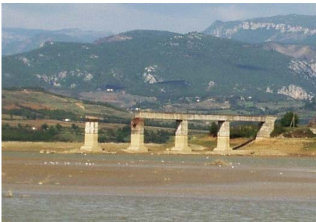
Jernbanebroen der fører lige ud i verdensrummet. Foto: BA, september 2005.
