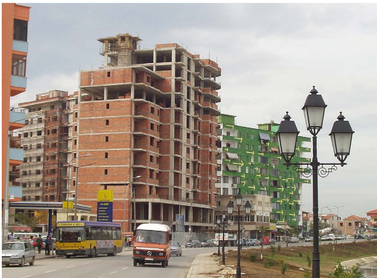
Nye huse ved Lana-floden – en km fra Tirana's centrum. Foto: BA, september 2005.
